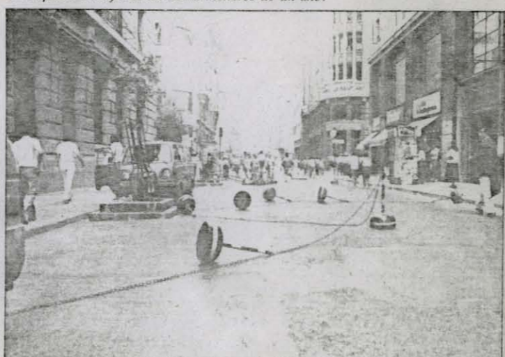
Barricadas en la calle Bandera.
